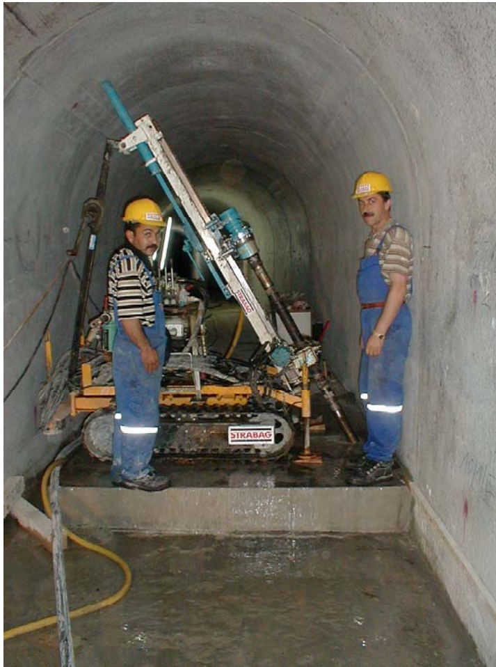
Abb. 11: Konsolidationsbohrung in der Galerie L1
