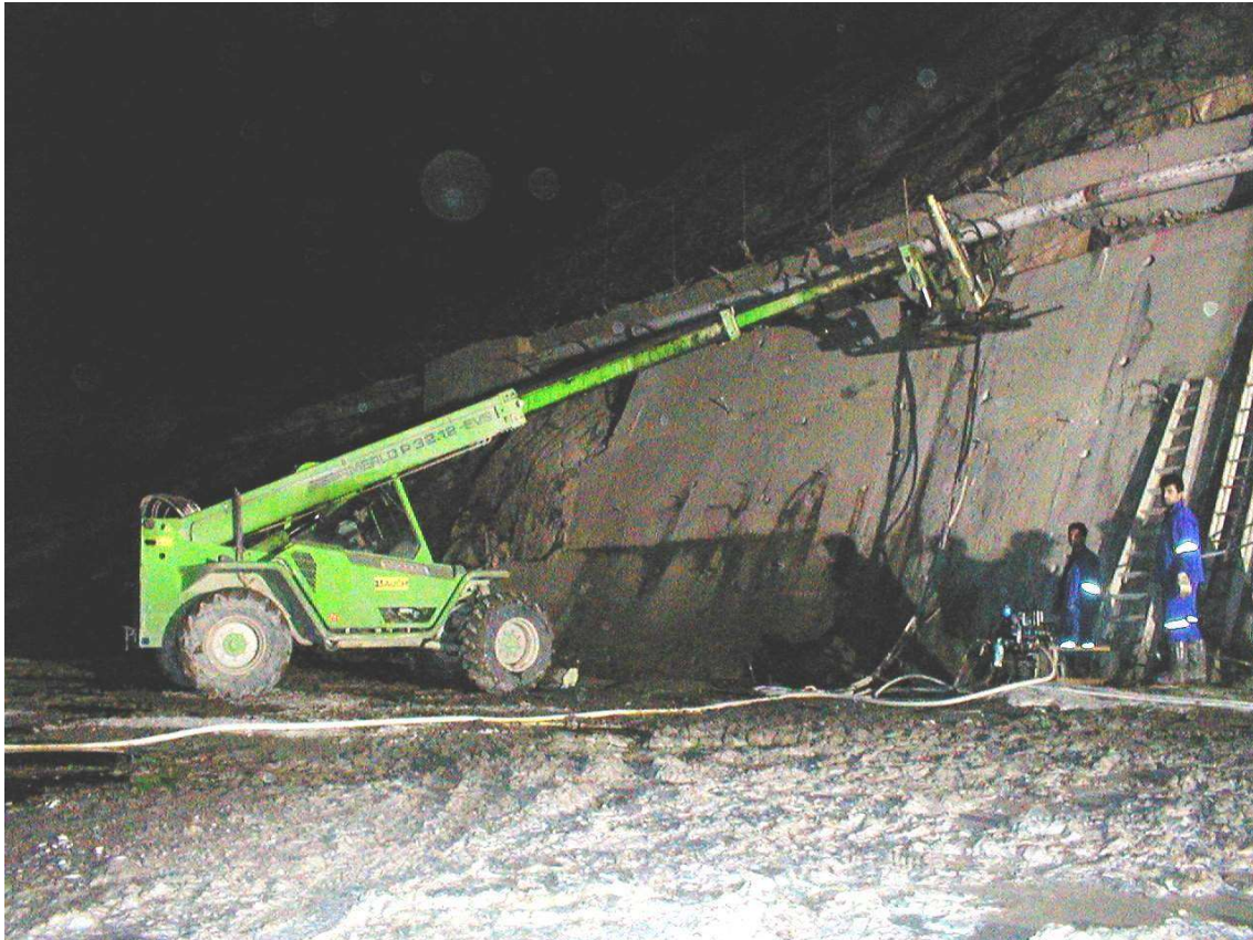
Abb. 10: Bohren in der Flanken für das Verpresswiderlager
