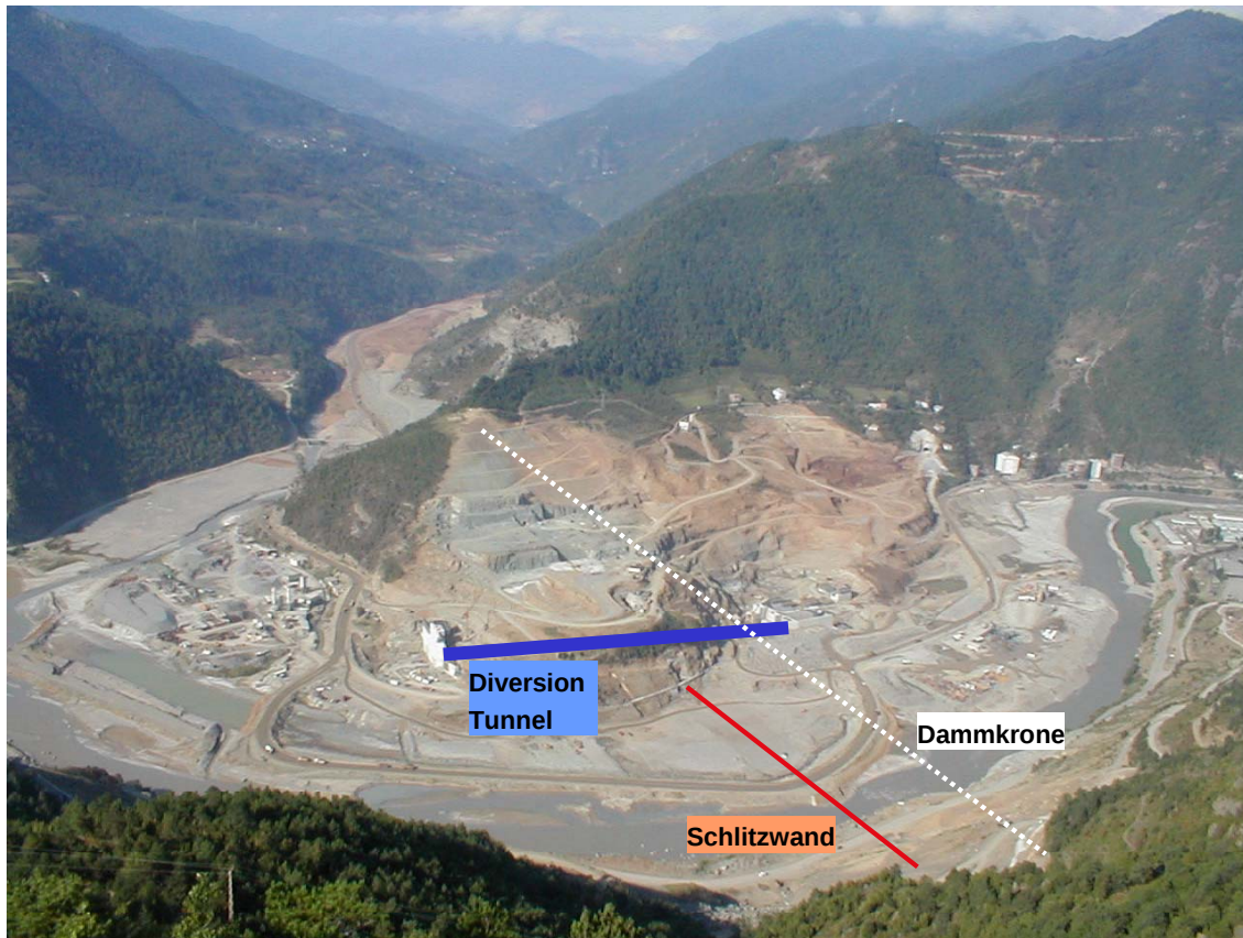
Abb. 8: Die Baustelle Borçka im Oktober 2001
